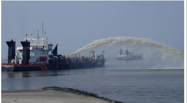
Baggerarbeiten in der Nordsee. Quelle: Wikimedia Commons / Nesse200, Lizenz: CC BY-SA 3.0
